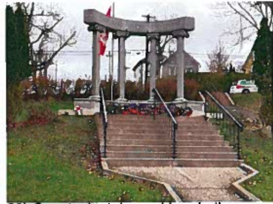
20) Cenotaph stairs and handrails
